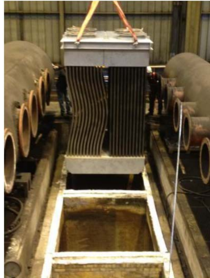
Echangeur de préchauffage d'air sur fumées de fours à gaz
