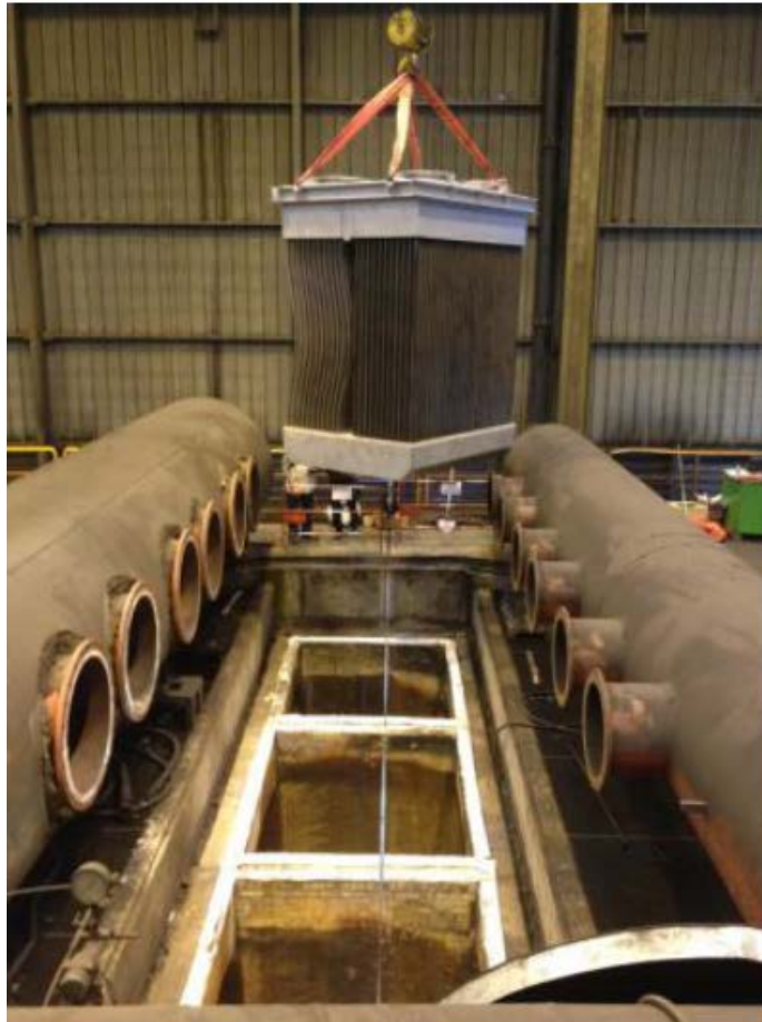
Echangeur de préchauffage d'air sur fumées de fours à gaz
